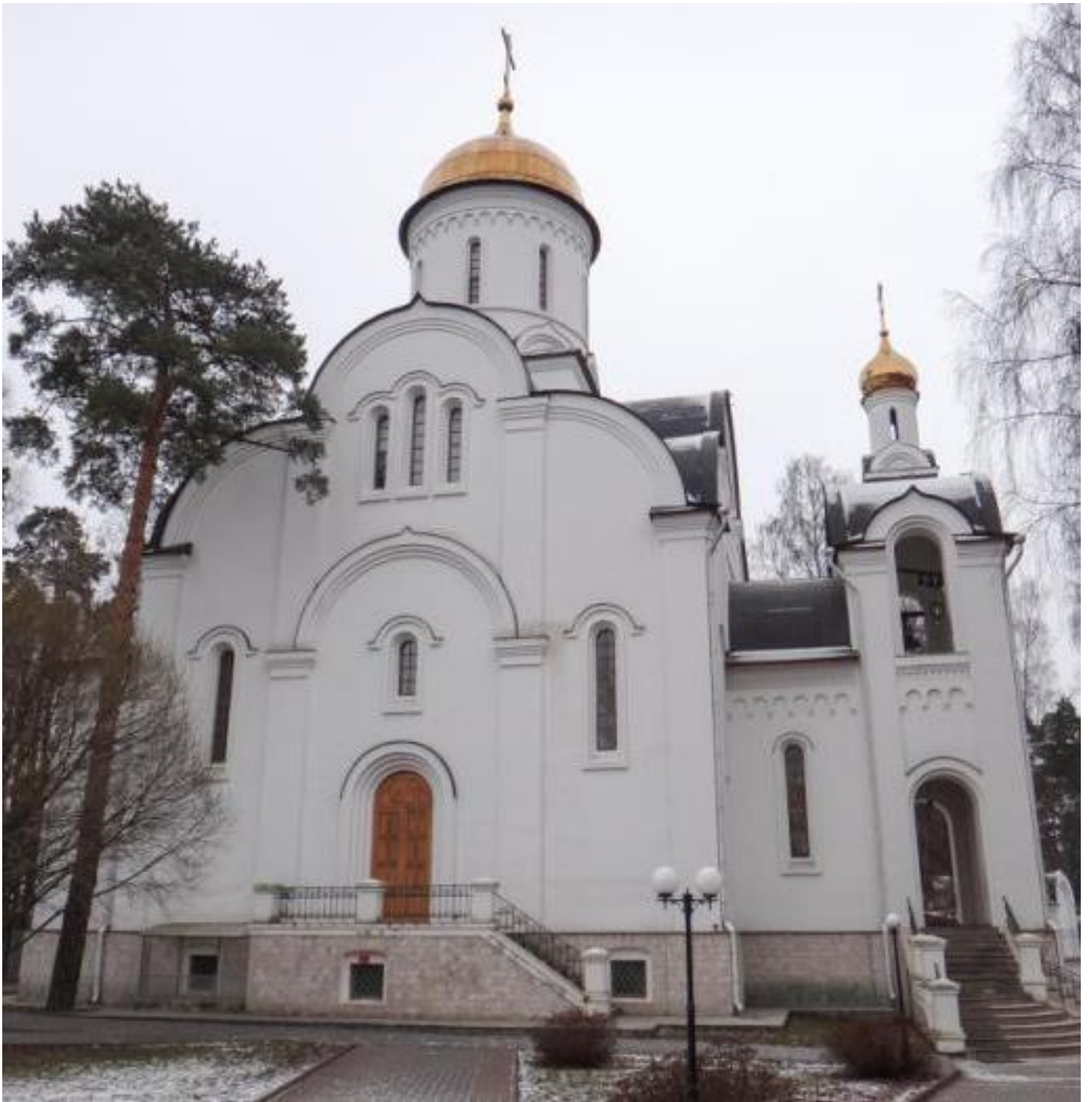
Церковь Воскресения Христова Москва адм.окр.Раменское поселок Быково
